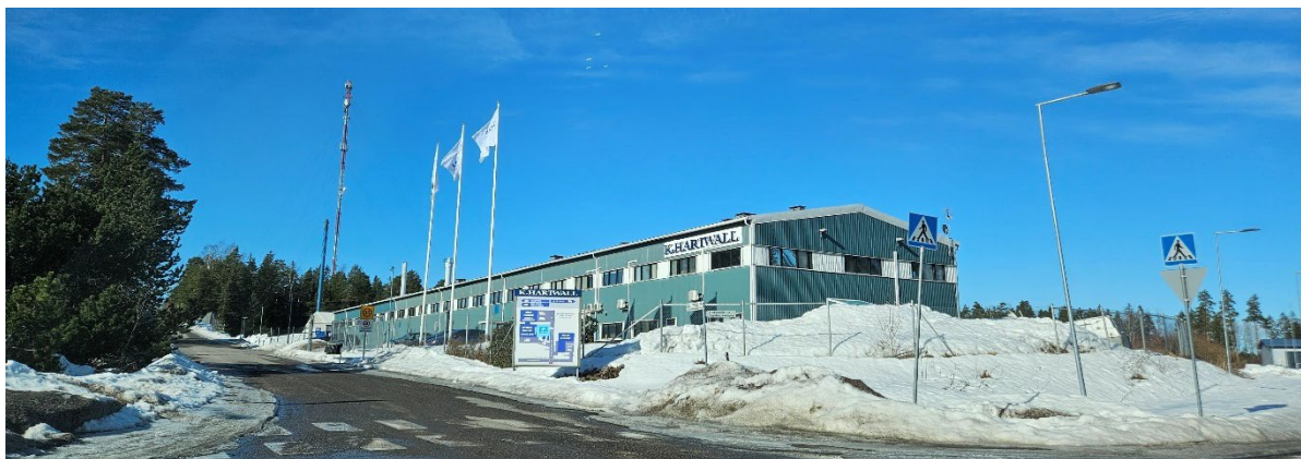
Figur 4.4. Arbetsplatsbyggnad vid Borgåleden.
