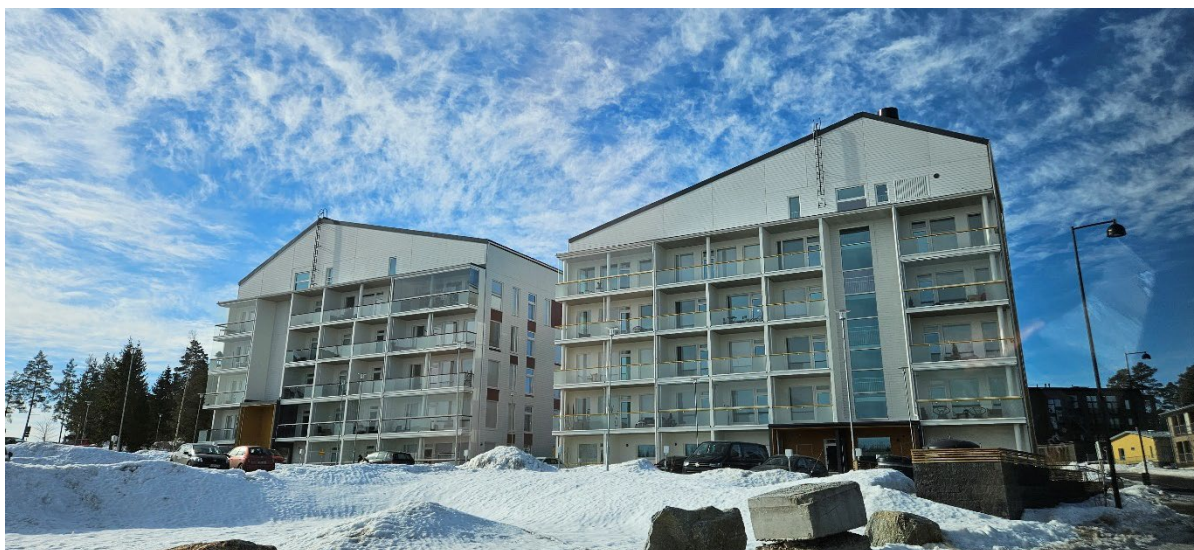
Figur 5.1. Byggda kvarter i Söderkulla.
