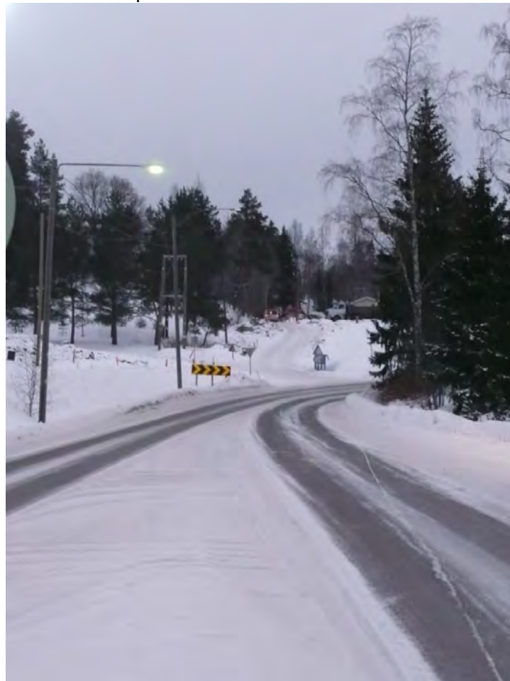
Kuva 5. Pornaistentien ja Snickarbackantien liittymän kuuset haittaavat näkyvyyttä.
