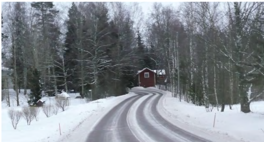
Bild 3. På bilden framkommer den för Borgnäs vägen typiska geometrin. Längst fram på bilden syns en tjälkada.
