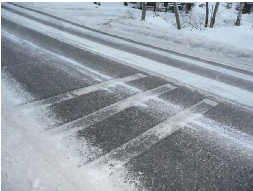
Kuva 4. Tärinäraidat Annanbackantien liittymän kohdalla.
