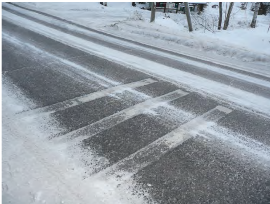
Bild 4. Vibrationsmarkeringar vid Annanbackavägens anslutning.
