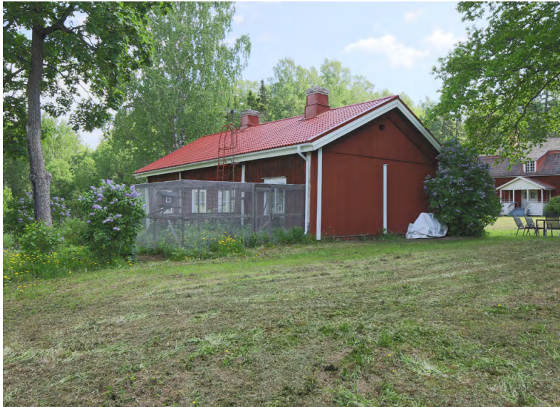
← Sivurakennuksen etelän- ja lännenpuoleiset julkisivut.
