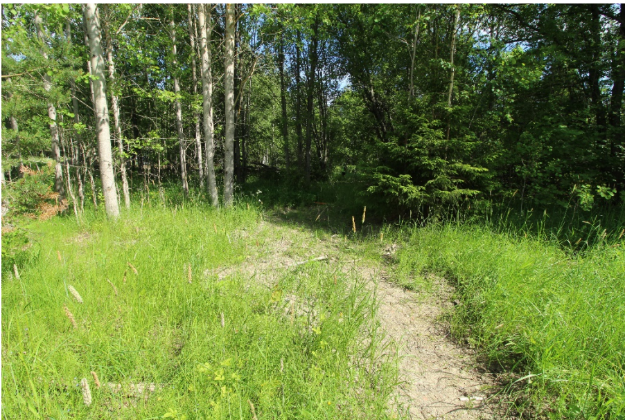
AKDG5858:24. Söderkullan tiilitehtaan/Stor-Massbyn kylätontin poikki kaivetun vesijohtolinjan kaivamisen jälkiä tiilitehtaan perustuksen luoteispuolella. Kuvattu lännestä. Kuvaaja Tuija Väisänen.
