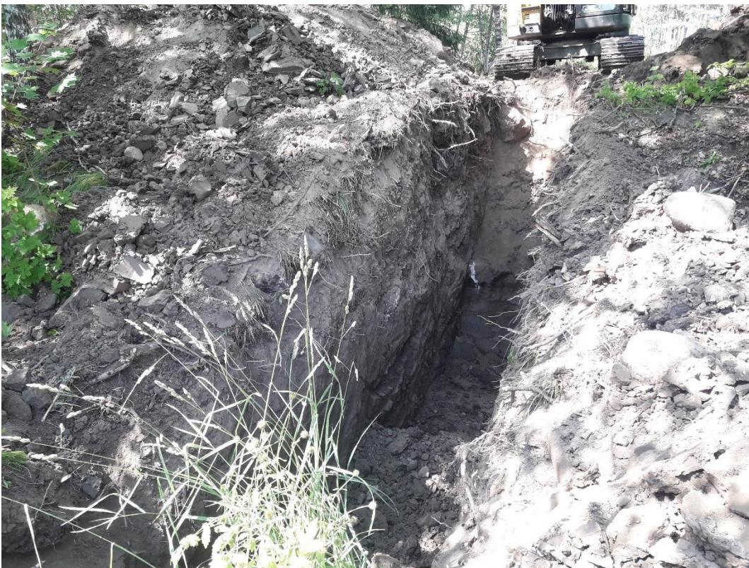
Kuva 08. Kuvassa näkyy valmiiksi kaivettu tutkimusojja OJA1. Ojasta löytyi yksittäisiä jättejakeita ja maaperä koostui savisesta, silttisestä sekä hiekkaisesta täyttömaasta noin 4 m syvyyteen. 4-4,5 m syvyydessä todettiin savinen oletettu luonnonmaa ja kaivu lopetettiin noin 4,5 m syvyyteen.
