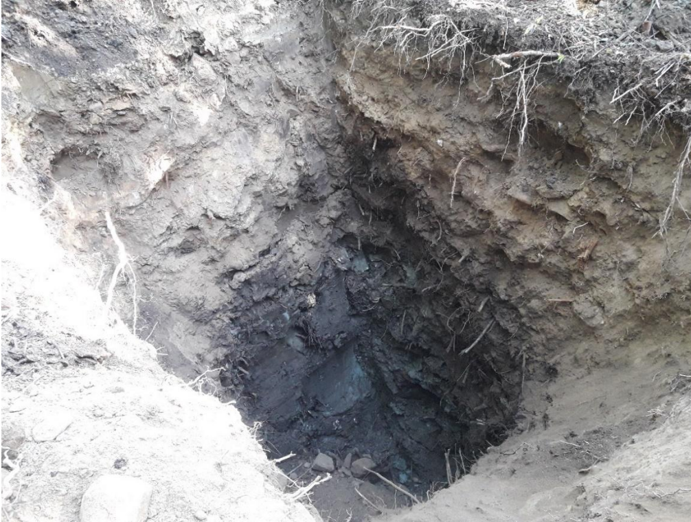
Kuva 01. Kuvassa näkyy kaivettu koekuoppa KK1 noin viiteen metriin asti, ja täten koko kuopan profiili. Yksittäisiä jättejakeita havaittiin 2-4 metrissä. Maa on ainakin 5 m syvyyteen asti hiekaista, savista ja siltistä täyttömaata, jossa on myös kiviä ja lohkareita.
