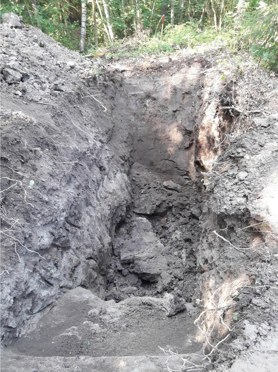
Kuva 10. Kuvassa tutkimusojja OJA3 kaivettu noin 5 m syvyyteen. Maaperä on lähes kauttaaltaan savista ja siltistä täyttömaata noin 4 metriin. Oletettu luonnonmaa (savinen hiekka) havaittiin noin 4-5 metrissä. Yksittäisiä jätejakeita todettiin täyttömaassa.
