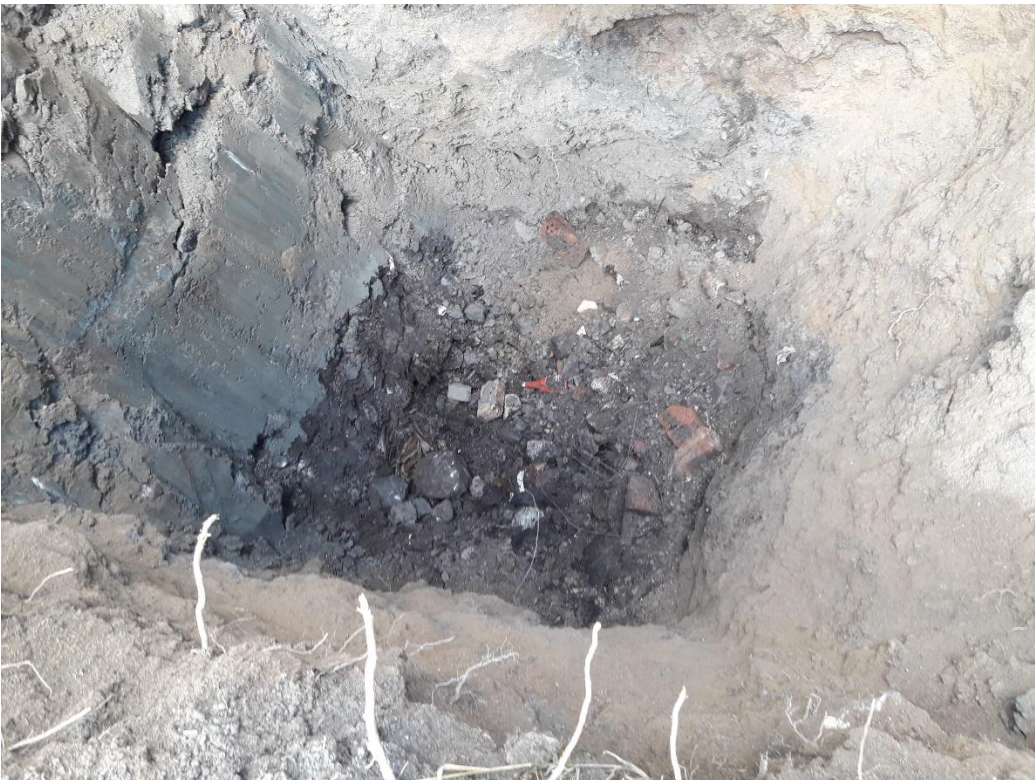
Kuva 04. Koekuoppaa KK3. Kaivannon pohjalla näkyy jätetäyttöä (rakennus- ja kotitalousjätettä) noin 2,8 m syvyydessä. Täyttömaa koostuu enimmäkseen hiekasta ja siltistä.
