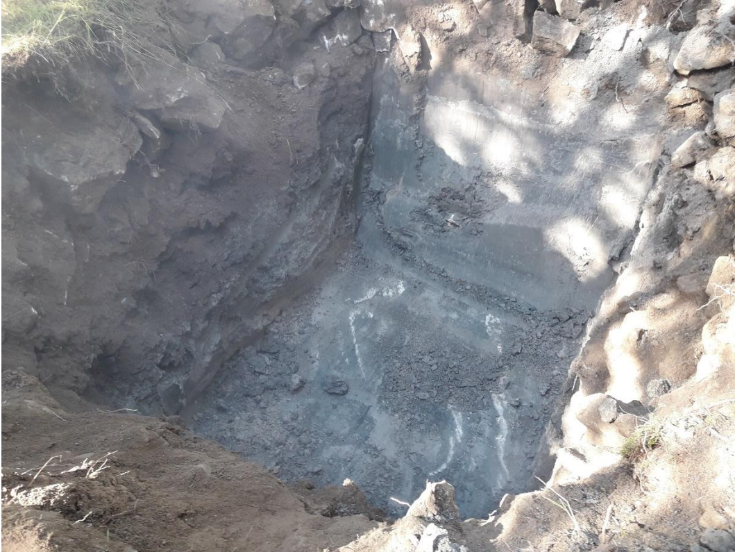
Kuva 07. Koekuoppa KK4. Kuoppa kaivettiin noin 2,3 m syvyyteen, jossa kaivu päättyi oletettavasti kallioon. Koekuopassa ei todettu jätettä ja maaperä oli silttistä, hiekkaista sekä savista täyttömaata kallioon asti.
