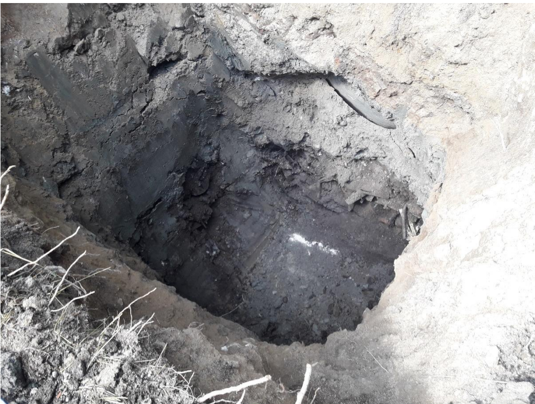
Kuva 06. Koekuopan KK3 päätepiste. Kaivu päättyi noin 3,9 m syvyyteen, jossa osuttiin kallioon tai isoon lohcareeseen. 3,3-3,9 m syvyydellä todettiin oletettu luonnonmaa, eikä jätetäyttöä enää havaittu. Maalaji oli tällä syvyydellä pääosin savea.
