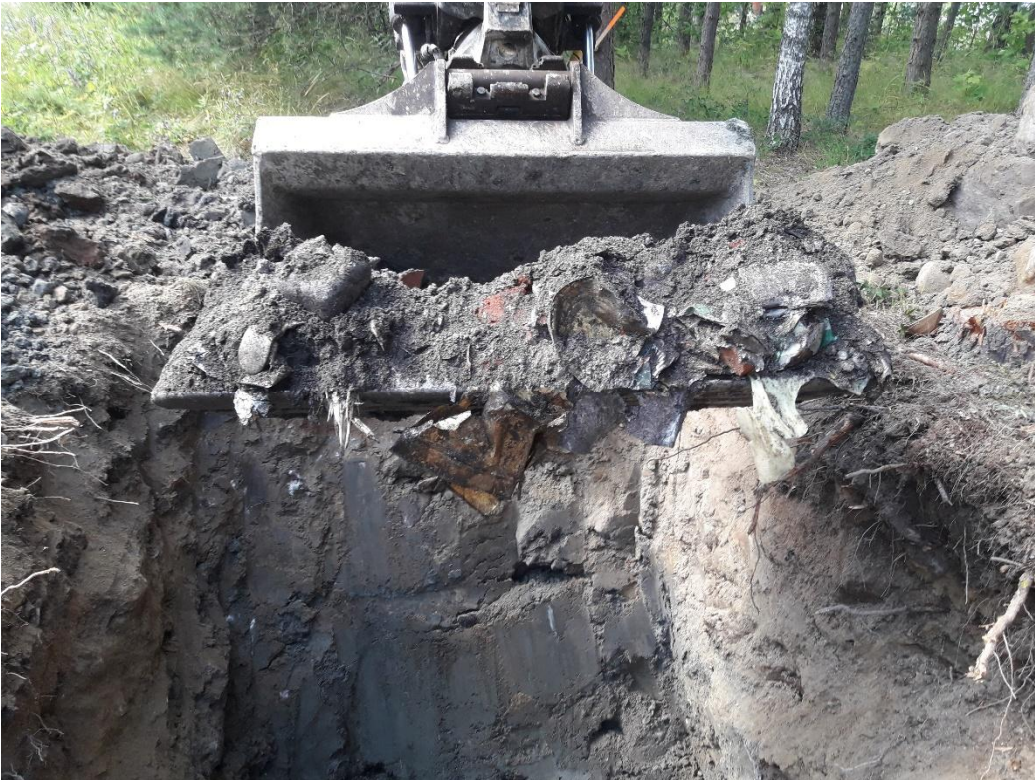
Kuva 03. Kuvassa kaivetaan koekuoppaa KK3. Kauhassa näkyy jätetäyttöä (kotitalousjätettä) 1,8-2,8 m syvyydestä.
