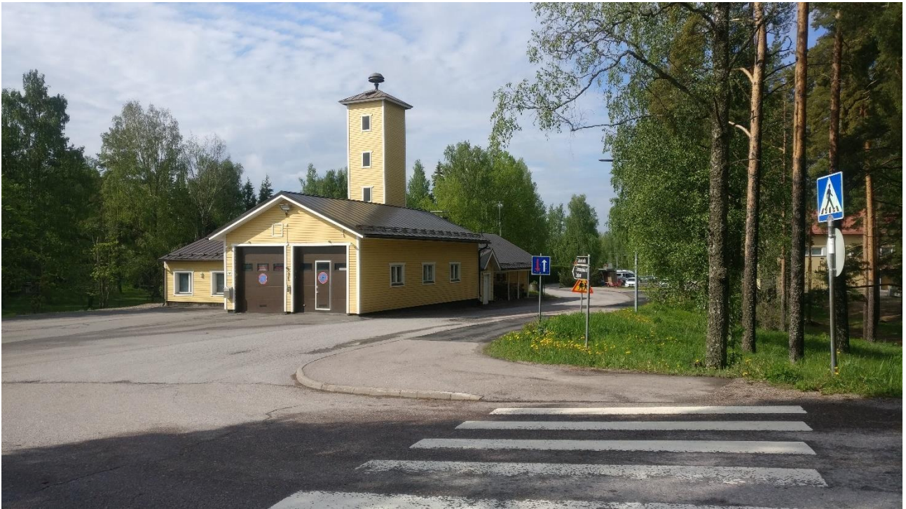
Kuva 24. VPK:n paloasema Kylänpääntieltä katsottuna.
