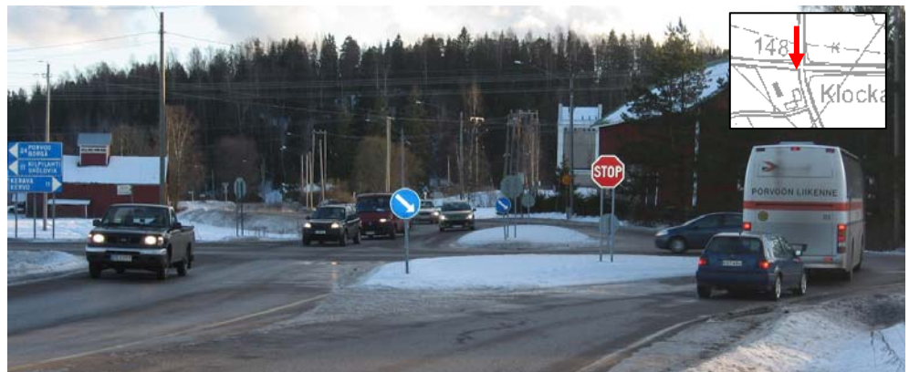
Kuva 10. Brobölen liittymä pohjoissuunnasta.
