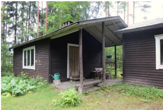
Vaakalimilaudoitus ja ruskea kuultokäsittely on tyyppinen julkisivukäsittely.
