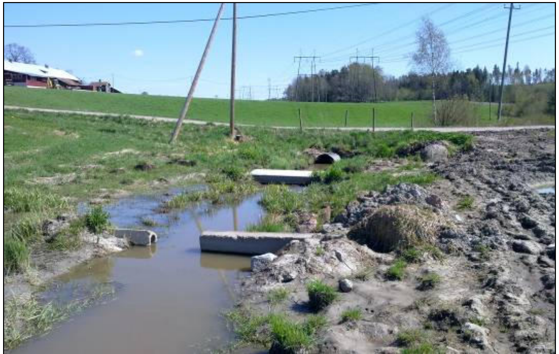
Kuva 22: Virtausrajoitteet ennen rumpua 11 aiheuttavat pientä tulvimista lähipelloille.
