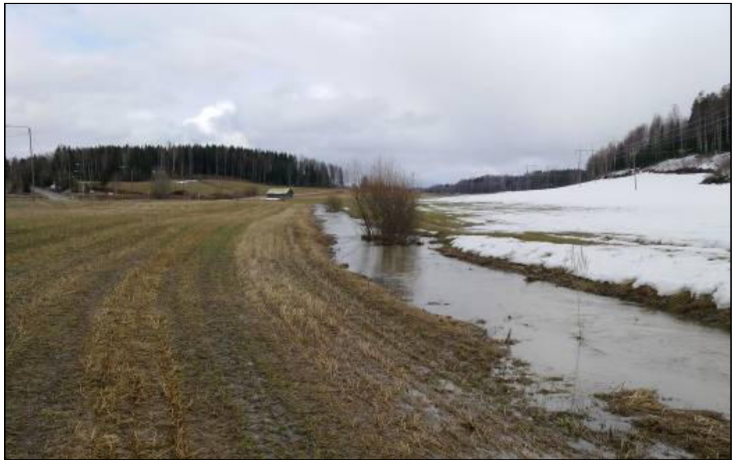
Kuva 24: Kasvillisuuden ja loivan pituuskaltevuuden aiheuttamaa puron uoman tulvimista peltoalueille Kuninkaantien lähetyvillä.
