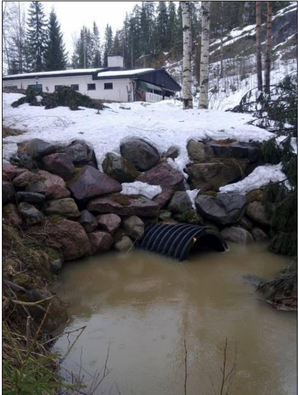
Kuva 10. Rumpu 7,yksityistie Jokivarrentien alapuolella.
