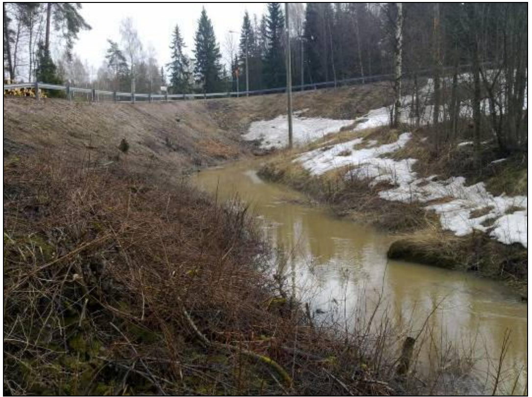
Kuva 20: Virtaamaa rajoittava Jokivarrentien rumpu d1000 nostaa vedenpinnan noin 30 rummun laen yläpuolelle.
