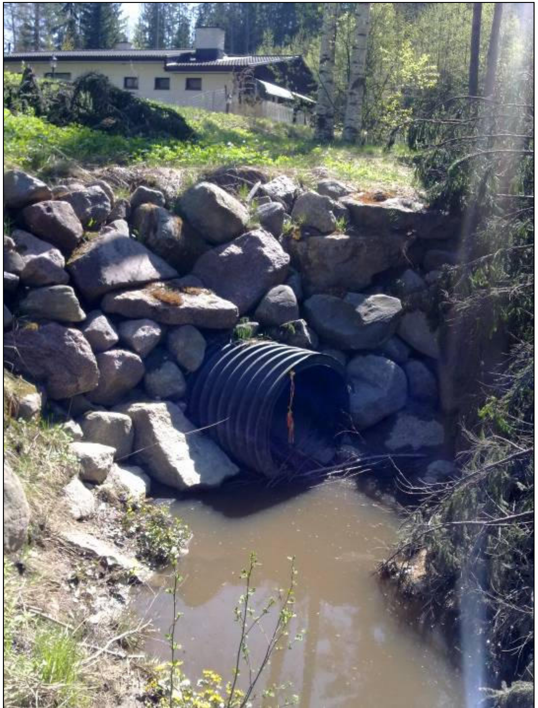
Kuva 21: Rummun 7 ympärystäyttö aiheuttaa täydellisen nousueste mahdollisille vaelluskaloille kesäaikaan.
