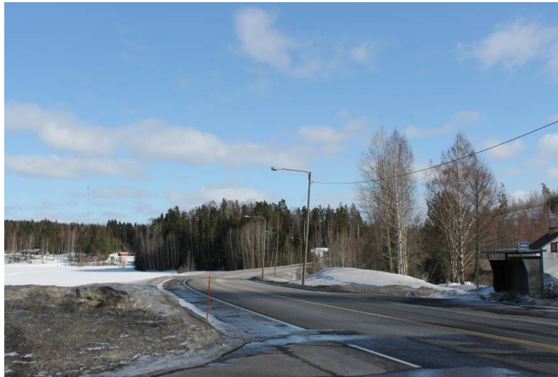
Kuva 6. Näkymä liittymästä itään päin on suhteellisen hyvä, mutta ei yllä 200 metriin, mikä on tavoite 80 km/h-nopeusrajoitusalueella. Ajoneuvojen nopeus on helposti nopeusrajoitusta suurempi, sillä kaarteiden takana on alamäki liittymää kohden, vaikkakin se liittymän kohdalla muuttuu lieväksi ylämäkeksi. Liittymän kohdalla on ajoratojen välillä kaksi keltaista viivaa.
