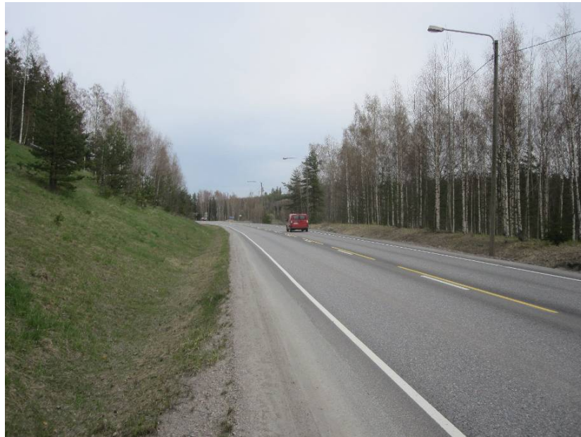
Kuva 10. Liittymävaihtoehto B sijaitsee kuitenkin ongelmallisesti lähellä mutkaa, joten näkyvyydet idän suuntaan ovat erittäin heikot. Liittymän kohdalla on myös suhteellisen korkea mäki Bastukärrin suuntaan, joka jouduttaisiin louhimaan liittymän tieltä. Kuva on otettu lännestä itään päin.
