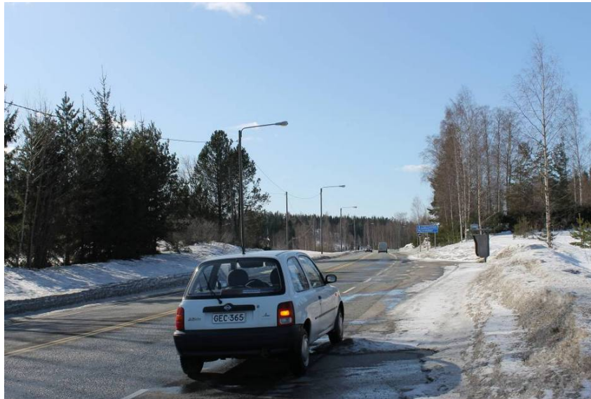
Kuva 7. Näkymä liittymästä länteen on myös suhteellisen hyvä, mutta ei yllä 200 metriin, mikä on tavoite 80 km/h-nopeusrajoitusalueella.
