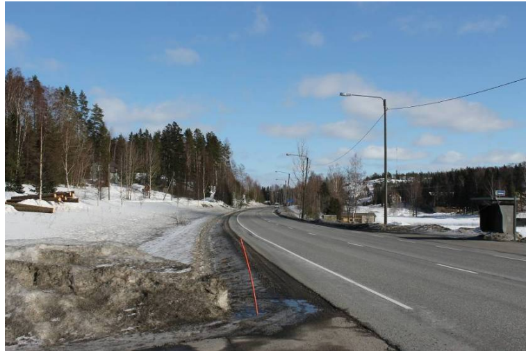
Kuva 12. Näkyvyys idän suuntaan on suhteellisen hyvä, mutta ei yllä 200 metriin, mikä on tavoite 80 km/h-nopeusrajoitusalueella. Liittymäalue on tasainen, eikä liittymän läheisyydessä ole keltaisia viivoja ajoratojen välissä.
