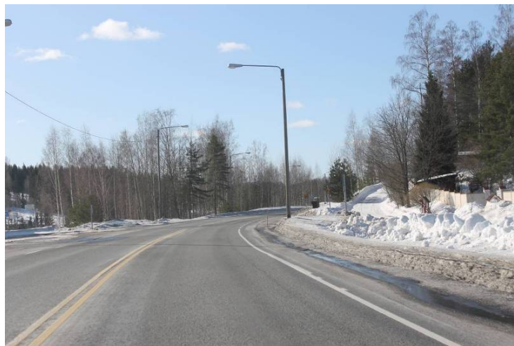
Kuva 11. Liittymä tulisi tämän mutkan taakse, joten näkyvyys liittymään idän suunnasta olisi erittäin heikko. Mutkassa ajoratojen välillä on kaksi keltaista viivaa. Kuva on otettu idästä länteen päin.
