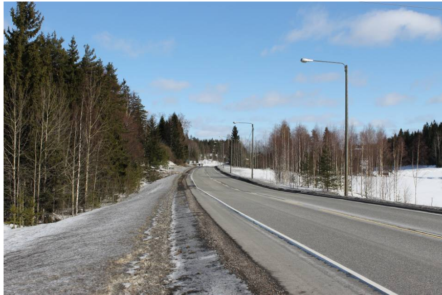
Kuva 14. Liittymävaihtoehto D sijaitsee nykyisten sähkölinjojen kohdalla. Näkyvyys idän suuntaan on suhteellisen hyvä, mutta ei yllä 200 metriin, mikä on tavoite 80 km/h-nopeusrajoitusalueella.
