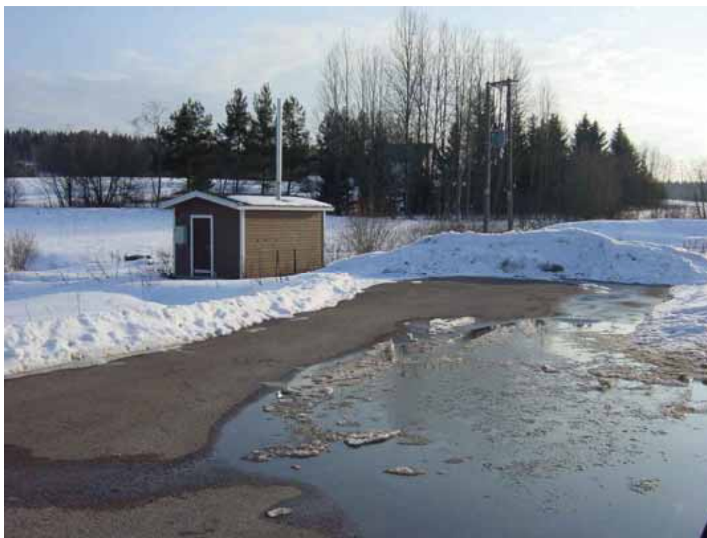
Bild 8 Pumpstation för avloppsvatten, mars 2009
