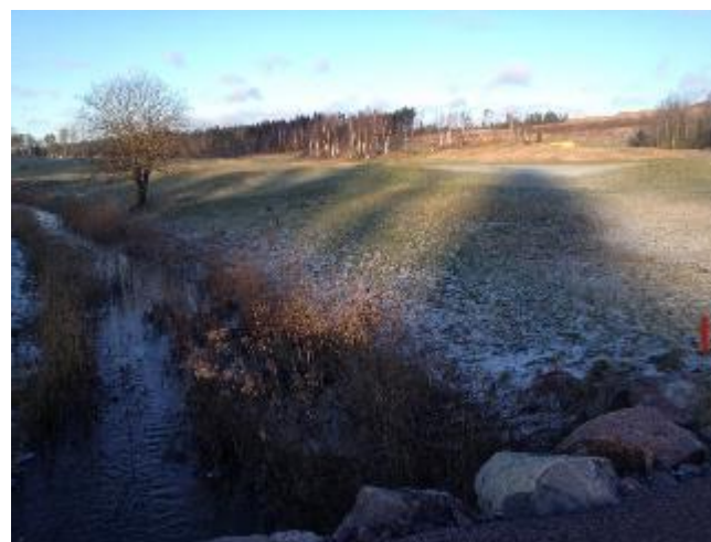
Bild 5.3. Cirka 3 meter höga fyllningar i en golfpark.
