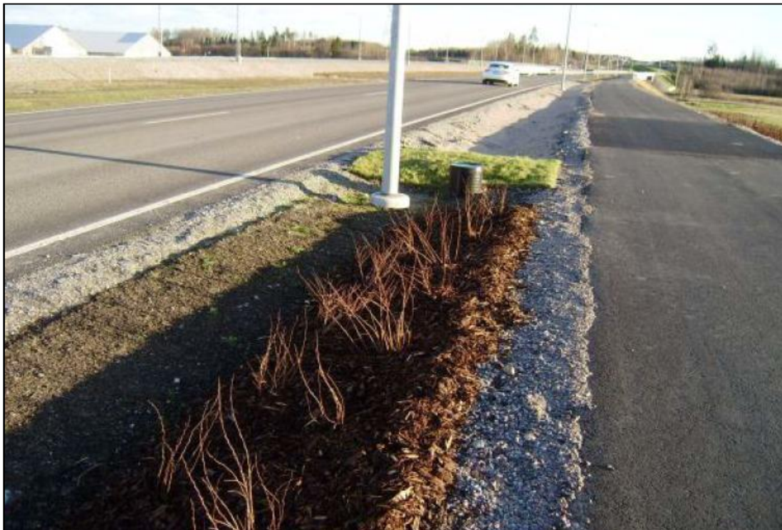
Kuva 8. Pääkadun vesien biosuodatus (Jormola, SYKE)
