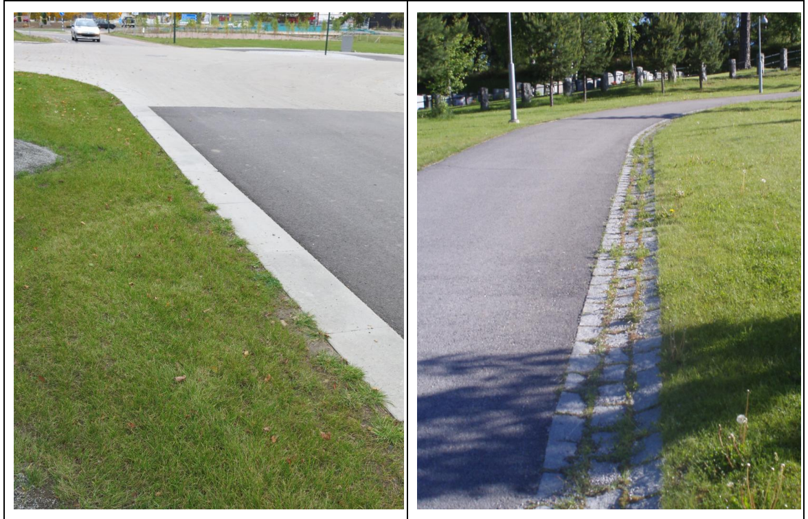
Kuva 12. Esimerkki matalasta reunakivestä ja hulevesikourusta (Pöyry)
