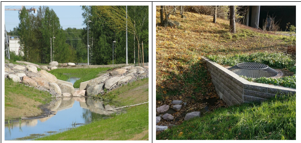
Kuva 11. Esimerkkejä viivytyksrakenteista (Pöyry)
