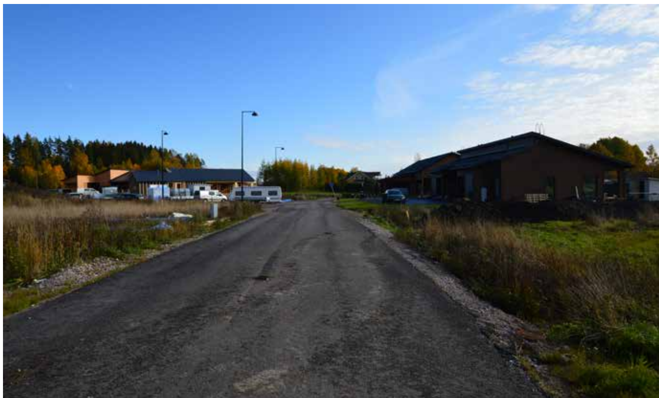
Suunnittelualue rajautuu rakenteilla oleviin Kuivaa-moraitin omakotitaloihin (lokakuu 2019).
