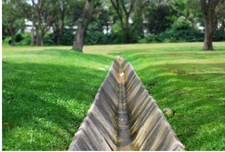
Kuvat: Kattovesien johtamista, kivipintainen imeytyspainanne
