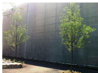
Dubbelfasad med stålgaller
