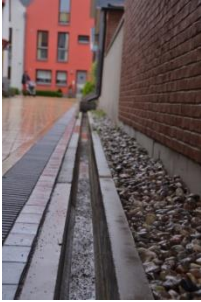
Kuvat: Kattovesien johtamista, kivipintainen imeytyspainanne
