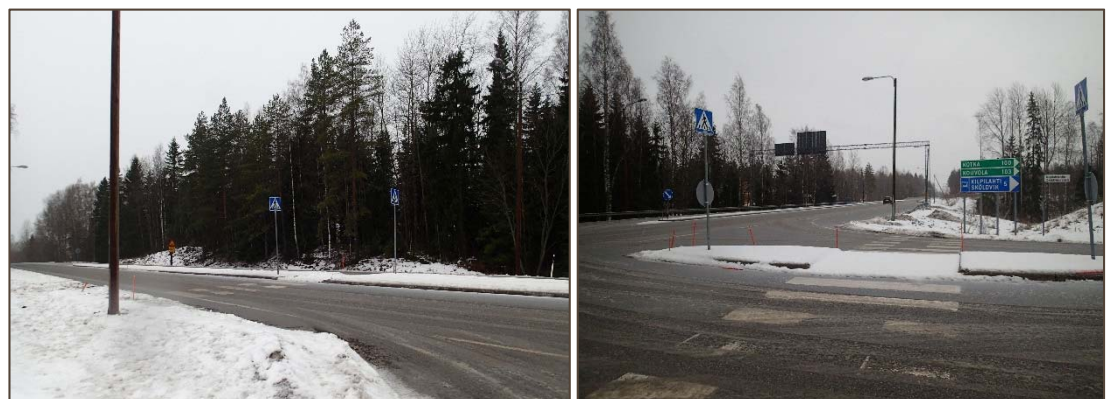
Kuva 2. Saarekkeelliset suojatiet Uuden Porvoontien (mt 170) ja Kilpilahdentien (mt 11746) liittymässä: vasemmalla Uuden Porvoontien ja oikealla Kilpilahdentien ylitys.
