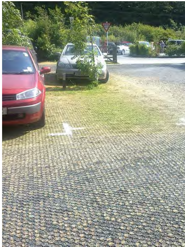
Kuva 4. Läpäisevää päällystettä pysäköintialueella, Englanti.
