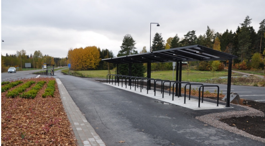
Bild. Anslutningsparkeringen vid Mårtensbyvägen.
