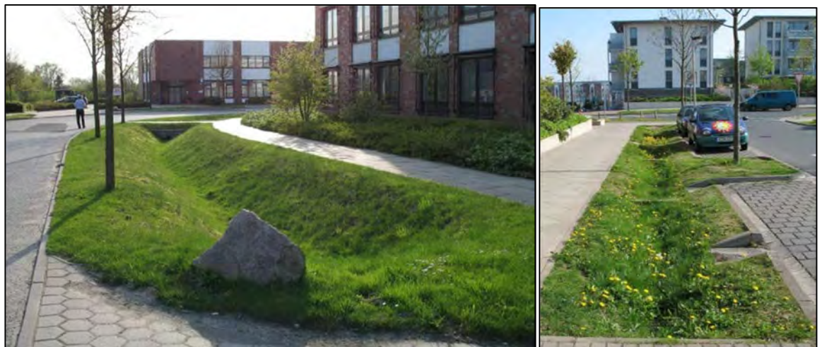
Kuva 13. Hulevesien johtaminen ja viivyttäminen viherpainanteissa (Kuvat: FCG)
