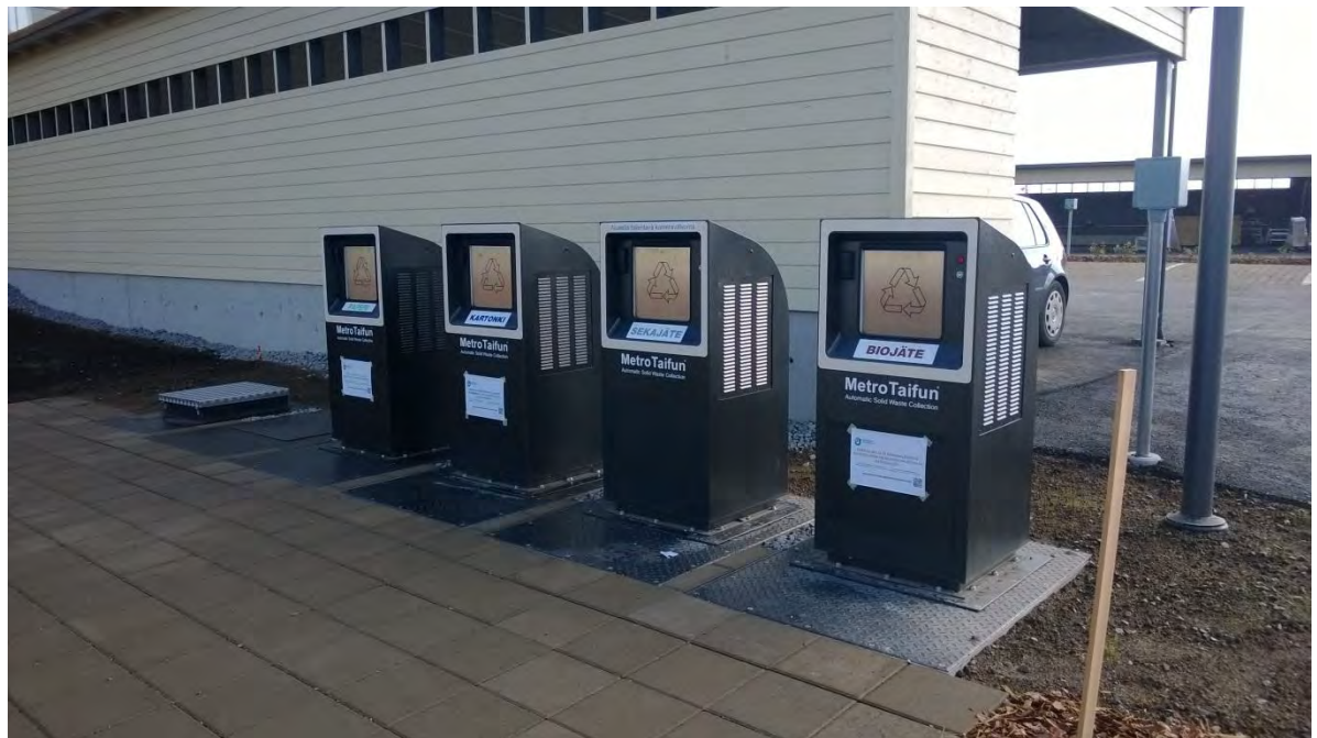
Kuva 28. Neljän jätelajin syöttöaukot Vuoreksen kaupunginosassa Tampereella (Lähde: MariMatic Oy)
