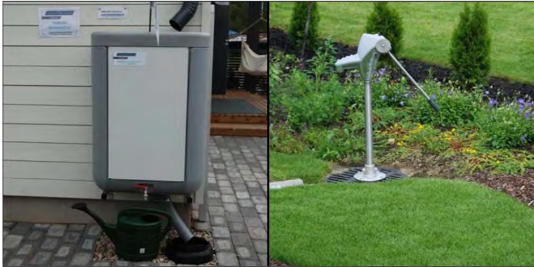
Kuva 10. Vasemmalla esimerkki 190 litran kattovesisäiliöstä. Oikealla tontin hulevesille varattu kaivo, josta vedet pumpattavissa hyötykäyttöön. (Tampere, Vuores . Kuvat FCG). Eko-Viikin korttelialueiden yhteisillä viljelypalstoilla hulevettä käytetään vastaavalla tavalla kasteluvetänä.
