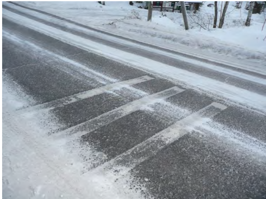
Kuva 4. Tärinäraidat Annanbackantien liittymän kohdalla.
