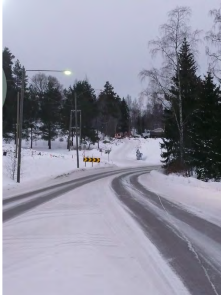
Kuva 5. Pornaistentien ja Snickarbackantien liittymän kuuset haittaavat näkyvyyttä.
