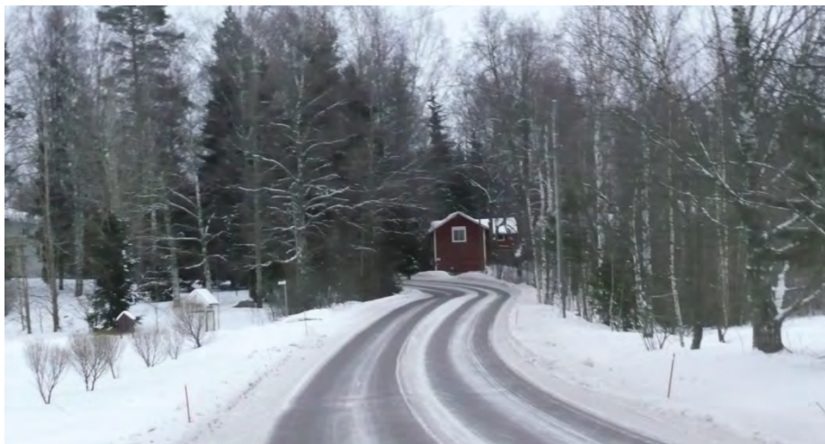
Bild 3. På bilden framkommer den för Borgnäs vägen typiska geometrin. Längst fram på bilden syns en tjälskada.
