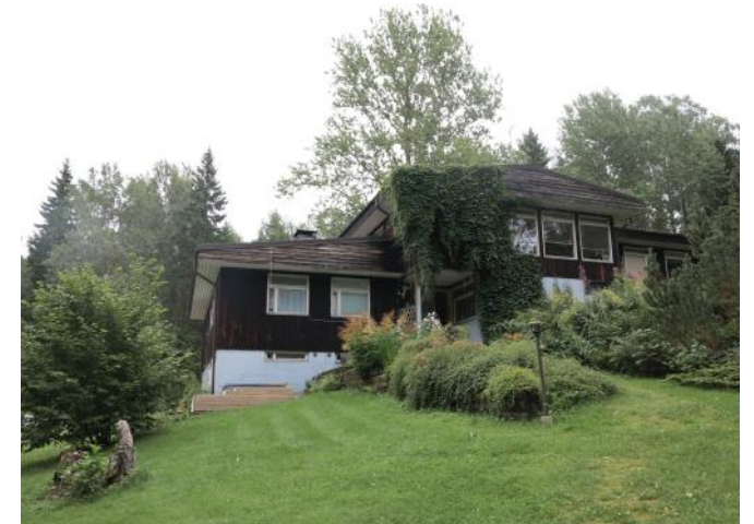
1950-luvulla rakennettu kurssikeskus.
