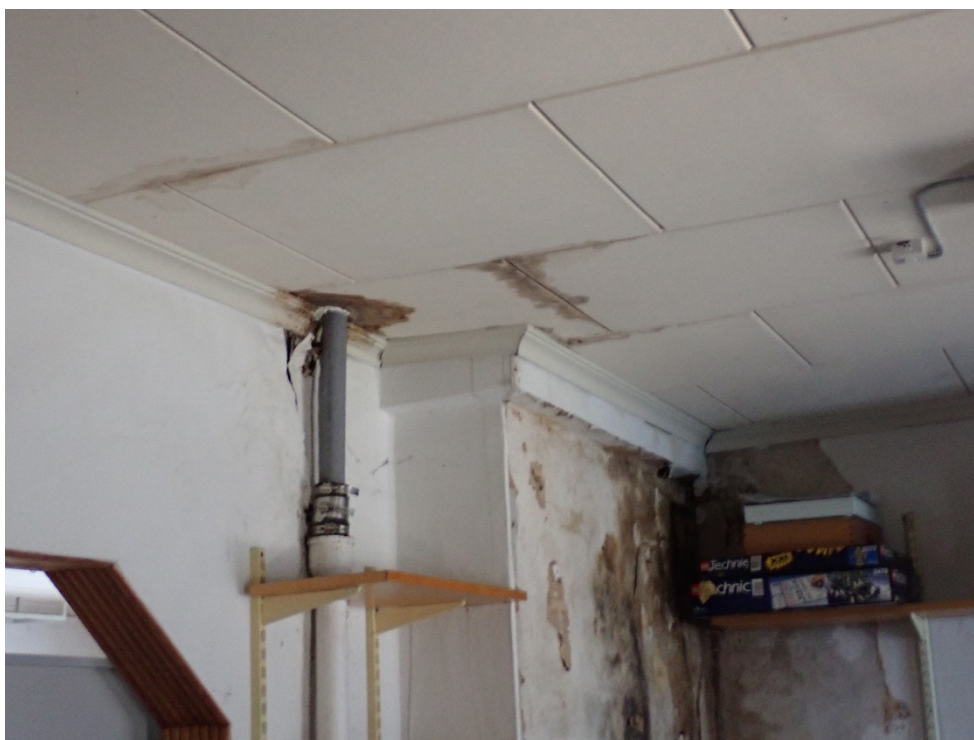
Vesikattovuotojen aiheuttamia vaurioita näkyvissä keskikerroksen katossa ja väliseinissä.
