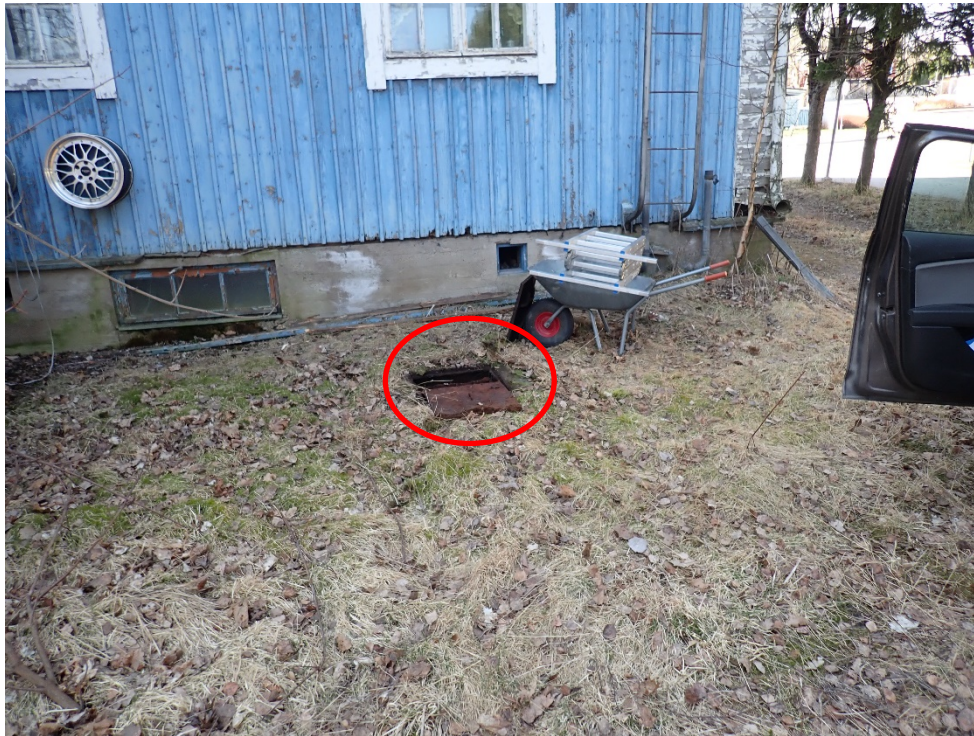
Pihalla olevan kaivon sijainti.
