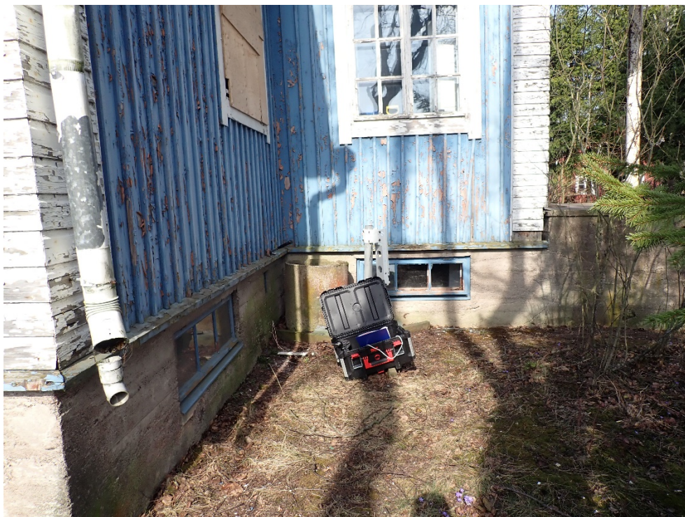
Rakennuksen itäisivulla on hyvä sokkelikorkeus.
