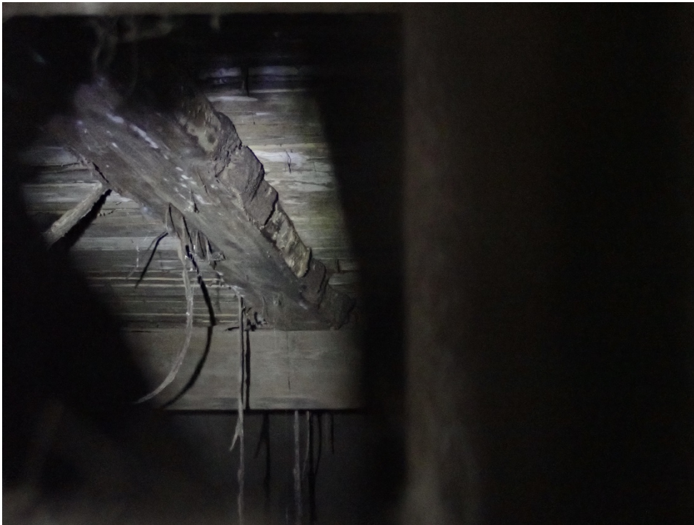
Ryömintätilaisen alapohjan lahoa ja homeista täytepohjaa.
