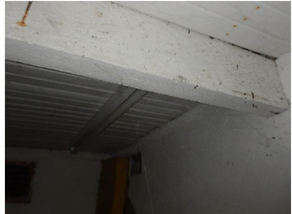
Kuva 31. Kellarin osalta välipohjat ovat betonirakenteisia.
