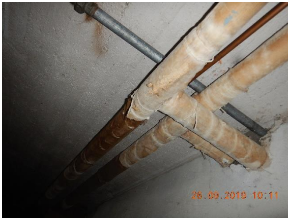
Kuva 91. Eristettyjä lämpöjohtoja kellarissa. Eristeet saattavat sisältää asbestia.
