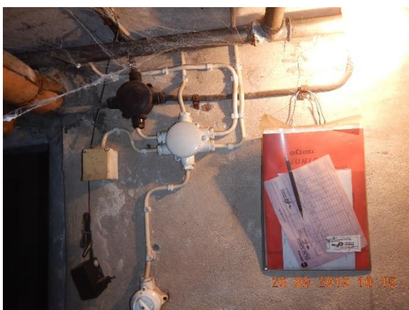
Kuva 109. Vanhoja asennuskalusteita. Pistorasia asennettu jälkeinpäin.
