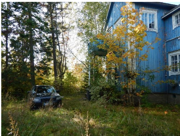
Kuva 45. Pesasistutukset ovat kiinni julkisivussa.
