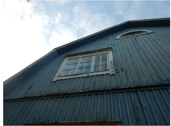
Kuva 55. Ullakon ikkuna on alkuperäinen ns. lunetti-ikkuna.
