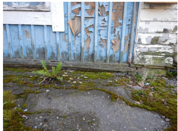
Kuva 15. Rakennuksen pohjoispäädyssä maanpinta on ulkoseinän alaosan tasalla. Sokkeli ja alapohjan tuuletusluukut ovat jääneet maanpinnan alle.
