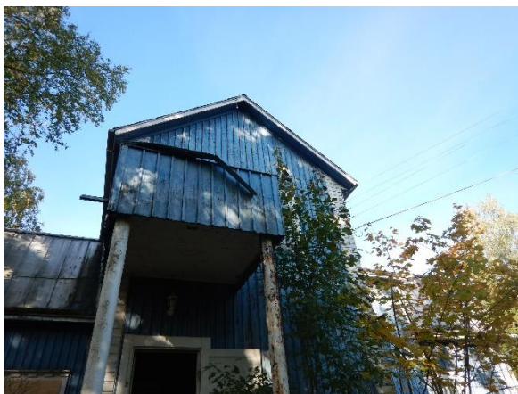
Kuva 41. Julkisivu idästä. Parvekkeen kaiteen pellitys on irronnut ja roikkuu parvekkeen ulkopuolella. Irtoavaan peltiin sisältyy henkilö- ja omaisuusriski.
