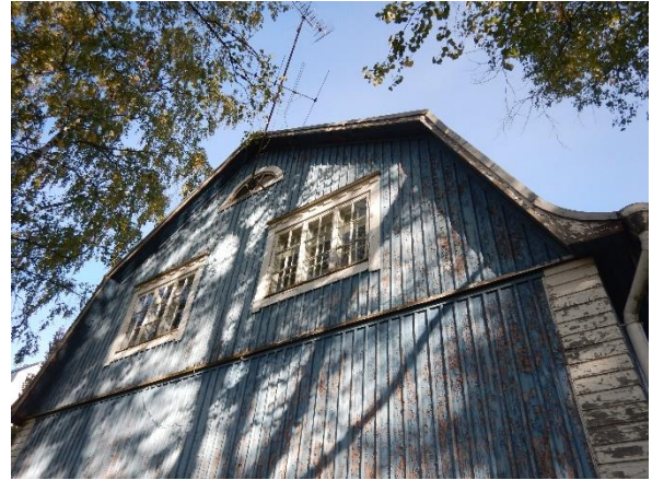
Kuva 40. Etelän puoleinen julkisivu.
