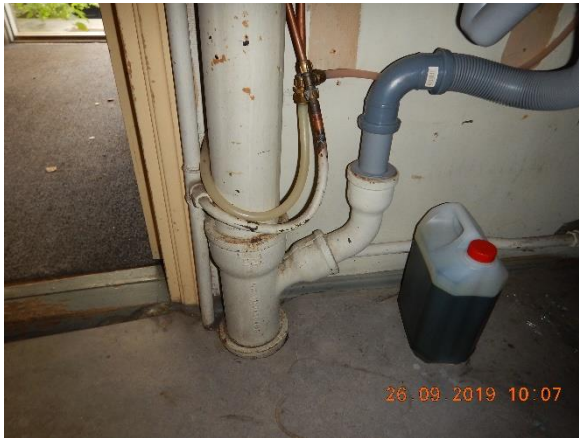
Kuva 95. Uusittu viemäri liitos alkuperäiseen valurautaviemäriin
