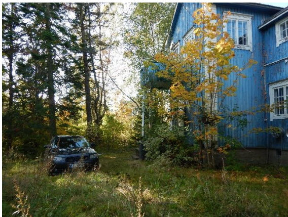
Kuva 4. Piha-alue on nurmipäällysteinen. Rakennuksen seinustoilla kasvaa puita ja pensaita lisäten ulkoseinärakenteisiin kohdistuvaa kosteusrasitusta.
