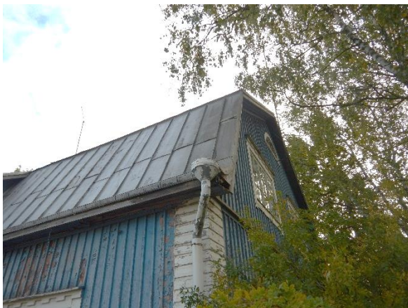
Kuva 9. Sade- ja sulamisvedet ohjataan jalkaränneillä syöksytorviin.
