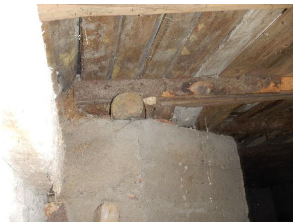
Kuva 22. Rossilaudoituksessa on silminnäkävää mikrobikasvustoa. Kuvassa näkyy tulisijan perustukset.
