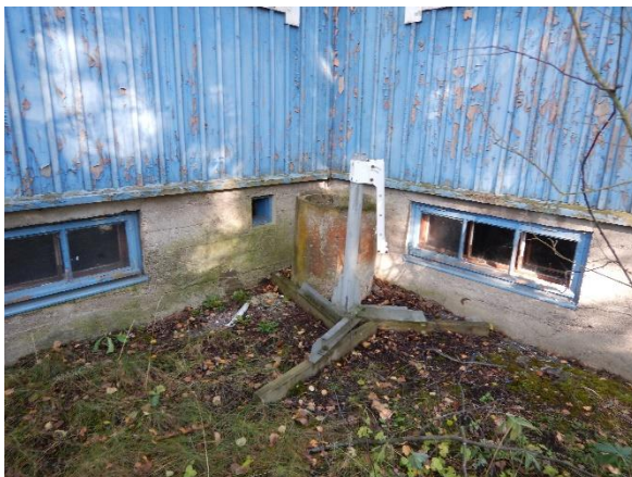
Kuva 14. Rakennuksen itäpuolen sokkeleissa esiintyy halkeilua ja jälkiä pitkäkestoisesta kosteusrasituksesta.
