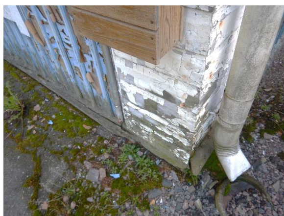
Kuva 50. Seinän alaosa on monin paikoin joko maanpinnan tasalla tai sen alapuolella. Seinä alaosan
