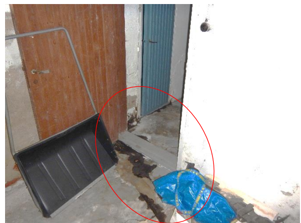
Kuva 23. Maanvastaisessa alapohjarakenteessa on silminnäkävää sienikasvustoa sekä merkkejä pitkäkestoisesta kosteusrasituksesta.
