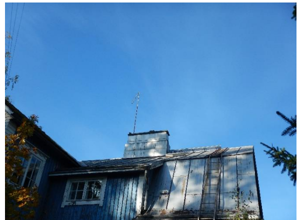
Kuva 65. Kohteeseen on asennettu talotikkaat ja kulkusilta katolle.
