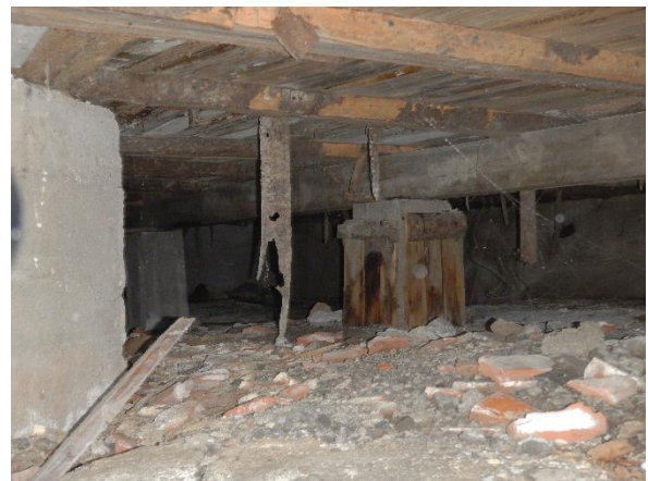
Kuva 21. Puista alapohjarakennetta tukevan betonipilarin muottilaudoitukset on jätetty paikoilleen. Muottilaudoitukset on lahovaurioitunut.
