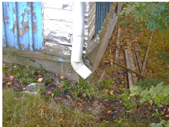
Kuva 10. Syöksytorvista tulevat vedet ohjataan rakennuksen vierustoille.
