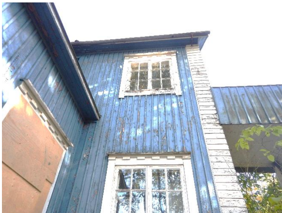
Kuva 43. Julkisivumaali lehteilee.
