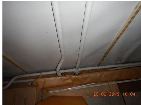
Kuva 92. Pinta-asenteisia lämpöjohtoja
