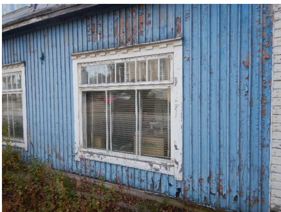
Kuva 52. Myymälän ikkunat ovat alkuperäisiä puuikkunoita.
