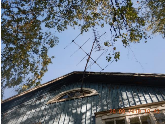
Kuva 112. Harava-antennit katolla.
