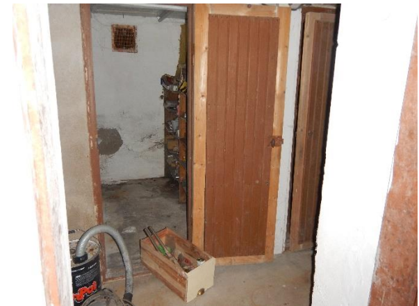
Kuva 68. Yleiskuva kellarin paneeliovesta
