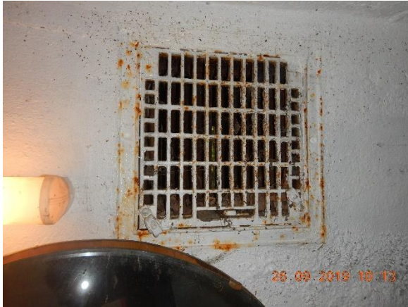
Kuva 105. Poistoilmasäleikkö
