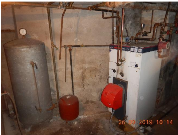
Kuva 89. Öljylämmityslaitteisto
