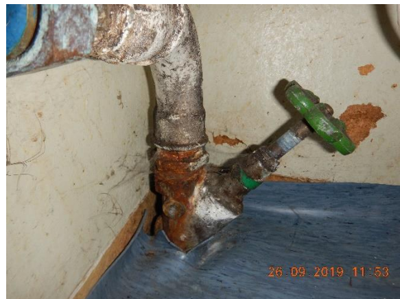
Kuva 84. Tonttivesijohto
