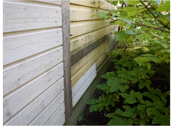
Kuva 39. Kasvillisuus on kiinni julkisivussa pohjoispäädyssä lisäten julkisivuun kohdistuvaa kosteusriskiä.
