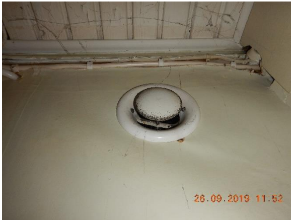
Kuva 91. Poistoilmaventtiili
