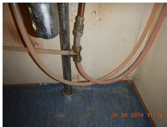
Kuva 86. Muovisia käyttövesijohtoja
