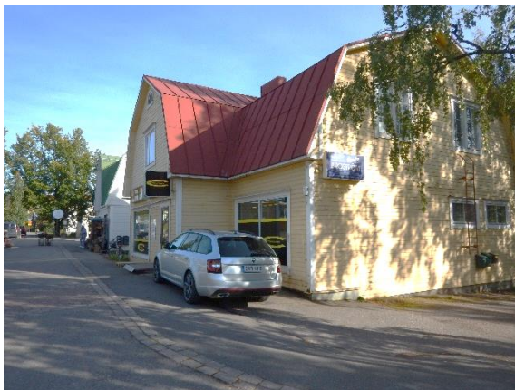
Kuva 2. Päälysteitä Iso Kylätien puolella
