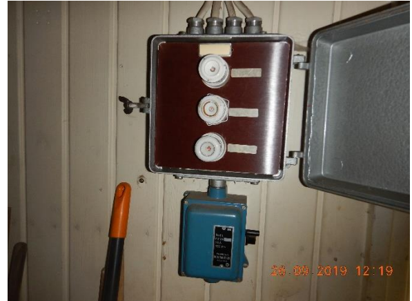
Kuva 70. Sähköpääkeskus.
