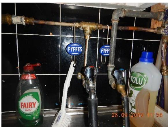
Kuva 85. Keittiön vesipistekytkenät
