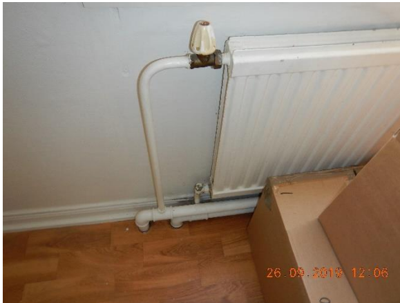
Kuva 77. Käsisäätöinen patteriventtiili
