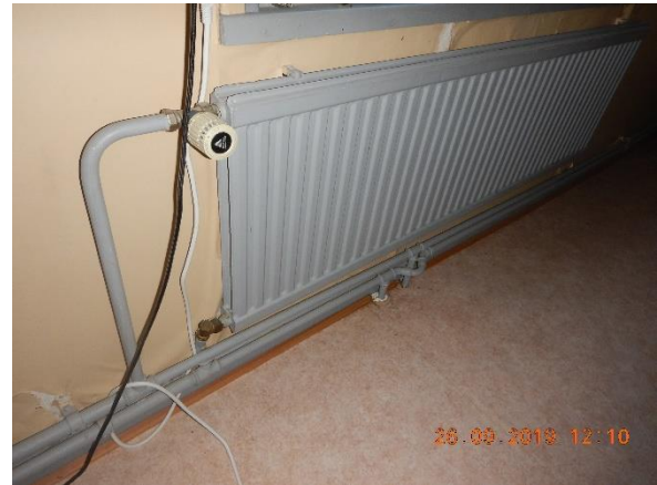
Kuva 78. Termostaattinen patteriventtiili
