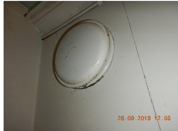
Kuva 92. Poistoilmaventtiili
