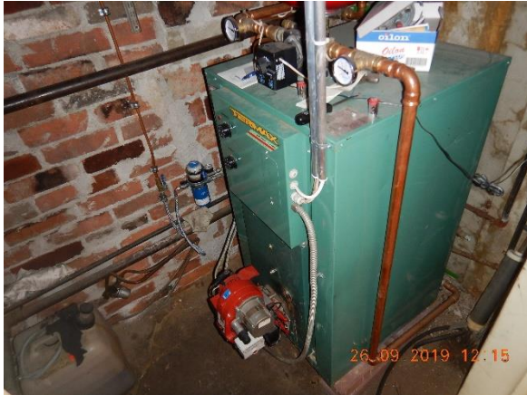
Kuva 69. Öljylämmityskattila.
