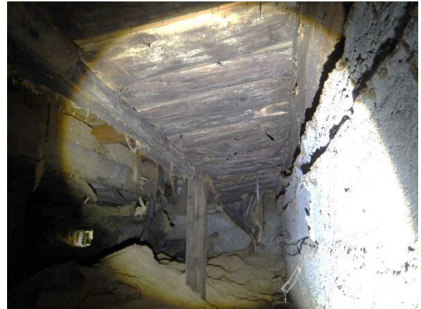
Kuva 18. Lahovaurioituneita alapohjarakenteita.
