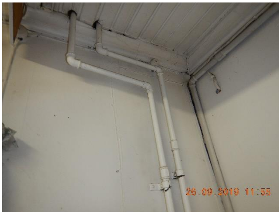
Kuva 75. Pinta-asenteisia lämpöjohtoja
