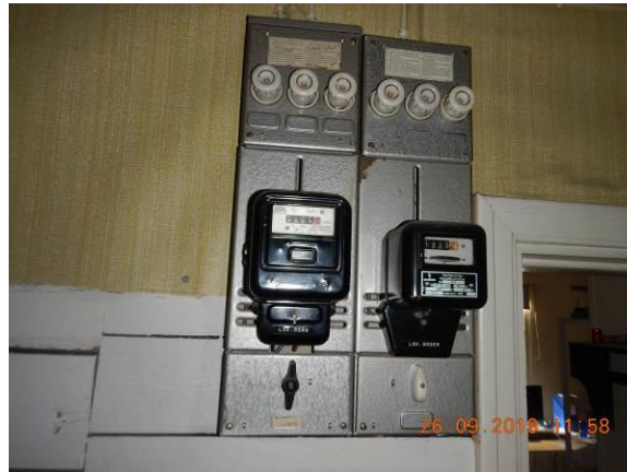
Kuva 94. Alamittauskeskukset.
