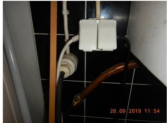
Kuva 96. Jälkiasennettu pistorasia.
