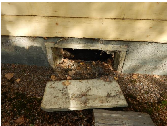
Kuva 19. Kohteessa havaittiin ainoastaan kolme rossitilan tuuletusluukkua, joista kaksi oli suljettuna.
