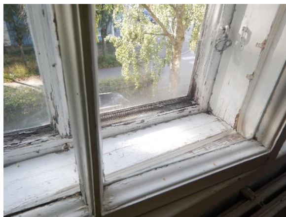
Kuva 47. Eteläpäädyn toisen kerroksen ikkunoiden ulkupuutteiden sisäpinnalla on havaittavissa kosteusjälkiä.
