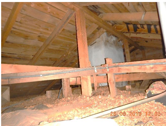
Kuva 22. Vuotojälkiä piipun läpiviennin kohdalla pihassa ja katon puurakenteissa.
