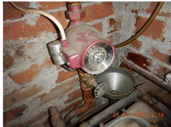
Kuva 76. Lämmitysverkoston kiertopumppu
