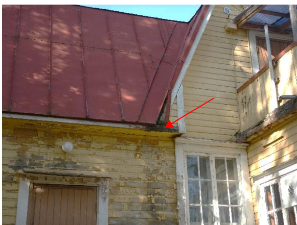
Kuva 30. Vesikatolta valuva vesi kastelee julkisivua. Räystäslaudoitus on lahovaurioitunut.
