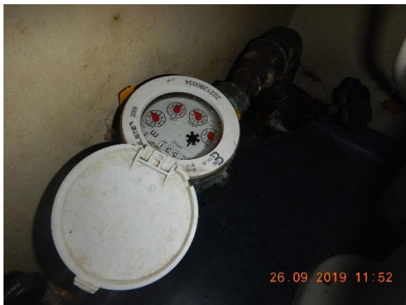
Kuva 83. Vesimittari
