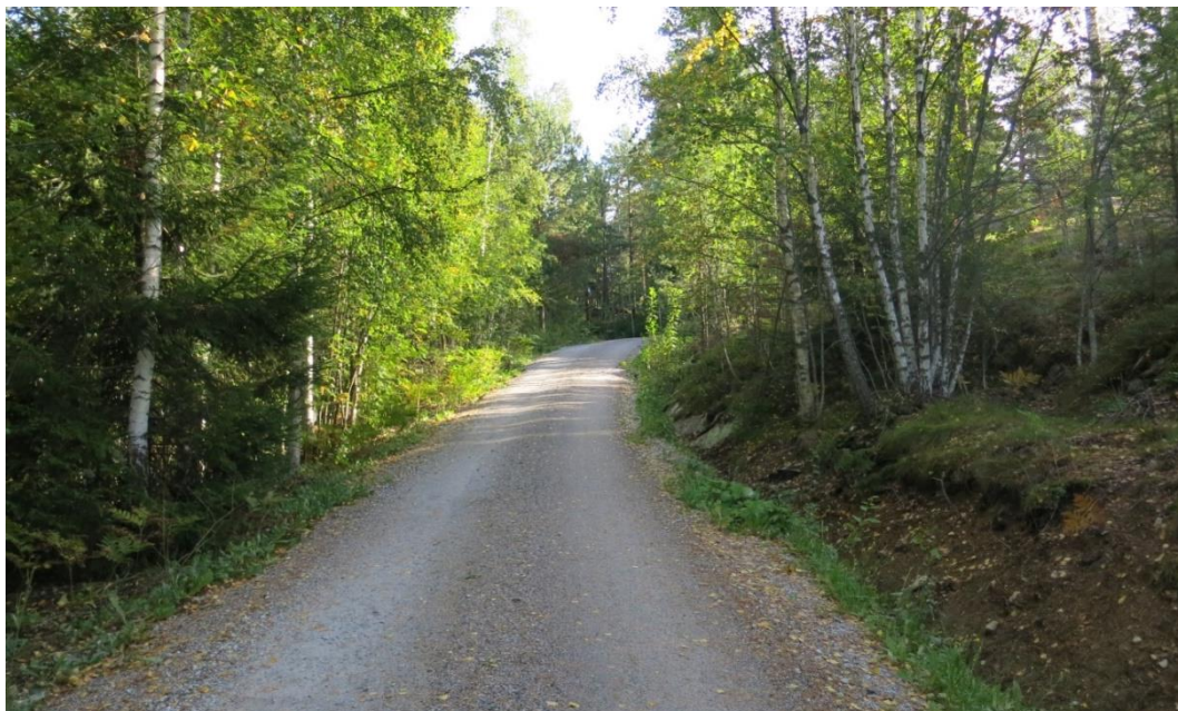
Kuva 5 Massbyn kaava-alueella nykyiset rakennetut tiet ovat päällystämättömiä ja tien kuivatus on hoidettu teiden varsille rakennetuilla avo-ojilla (AFRY Finland Oy).
