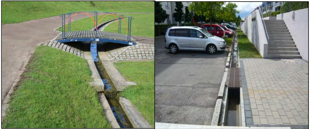
Kuva 8. Esimerkkejä avoimesta pienestä kourusta. Milton, Englanti ja Stuttgart, Saksa. kuvat FCG.
