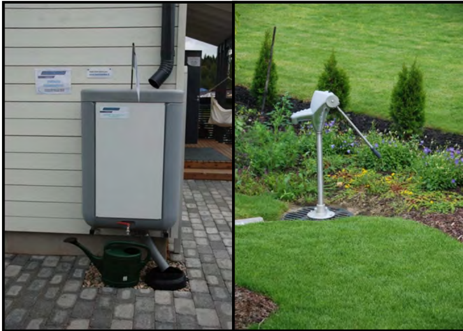
Kuva 6. Sadeveden varastointia kasteluvedeksi sadevesitynnnyrissä ja – kaivossa. Vasemmalla esimerkki 190 litran kattovesisäiliöstä. Oikealla tontin hulevesille varattu kaivo, josta vedet pumpattavissa hyötykäyttöön. (Tampere, Vuores . Kuvat FCG). Eko-Viikin korttelialueiden yhteisillä viljelypalstoilla hulevettä käytetään vastaavalla tavalla kasteluvetenä.
