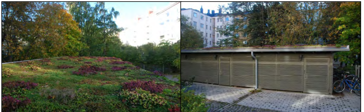
Kuva 7. Pihavaraston viherkatto, Helsinki. (kuva FCG)
