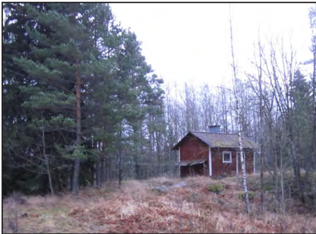
Purkukuntainen saunamökki alueella. Bastustuga i rivningsskick.
