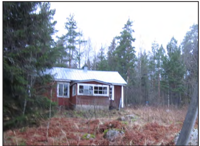
Purkukuntainen talo alueella. Hus i rivningsskick.
