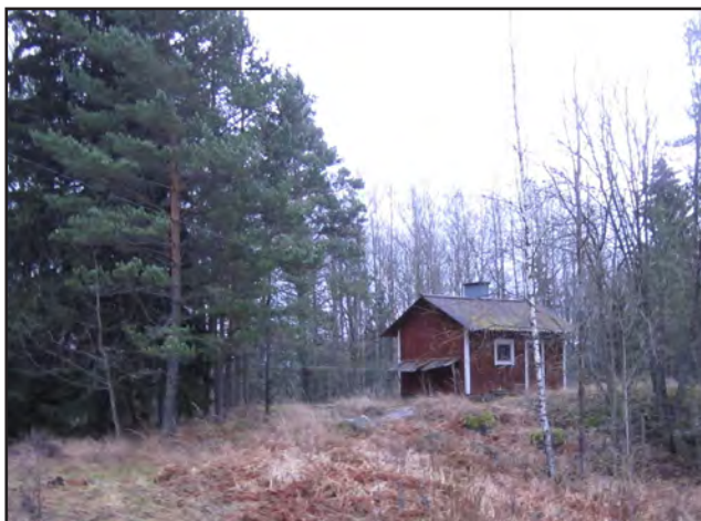
Purkukuntainen saunamökki alueella. Bastustuga i rivningsskick.
