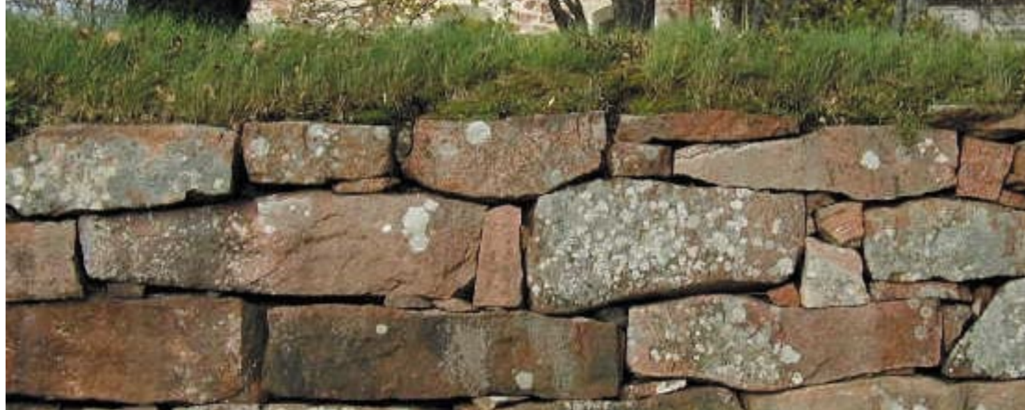
Kuvat yllä ja vasemmalla: irrallisista kivistä ladottu muuri Tasbynttien varren AK -kortteleissa. Piirustus on mittakaavassa liitteessä
