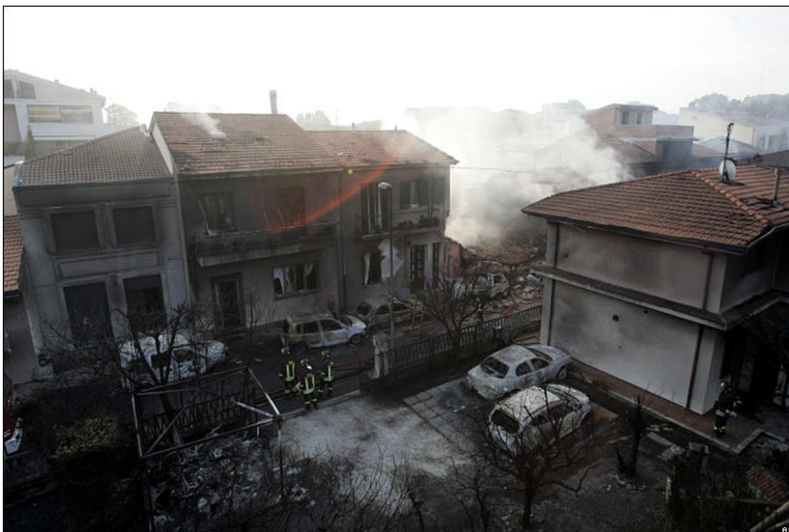
Kuva 8: Viareggion onnettomuuden seurauksia läheisille rakenteille ja autoille. Kaksi rakennusta sortui. Lähde: BBC News 42
