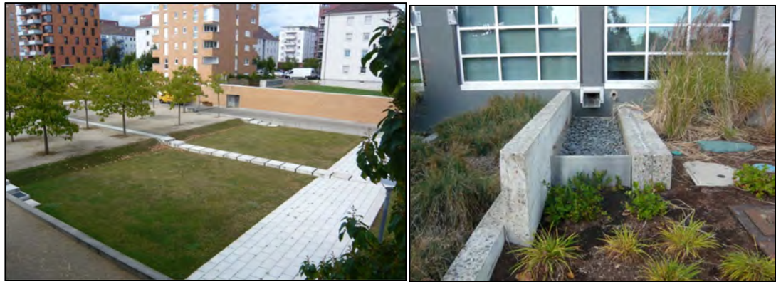
Kuva 12. Korttelin sisäinen Viivytys/tulva-allas (vasen kuva) ja syöksyputken yhteyteen rakennettu viivyttävä kivipesä. (Kuvat: FCG)
