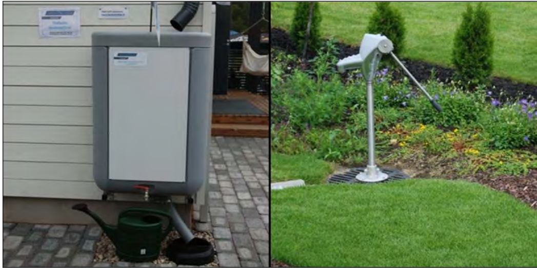
Kuva 10. Vasemmalla esimerkki 190 litran kattovesisäiliöstä. Oikealla tontin hulevesille varattu kaivo, josta vedet pumpattavissa hyötykäyttöön. (Tampere, Vuores . Kuvat FCG). Eko-Viikin korttelialueiden yhteisillä viljelypalstoilla hulevettä käytetään vastaavalla tavalla kasteluvetenä.
