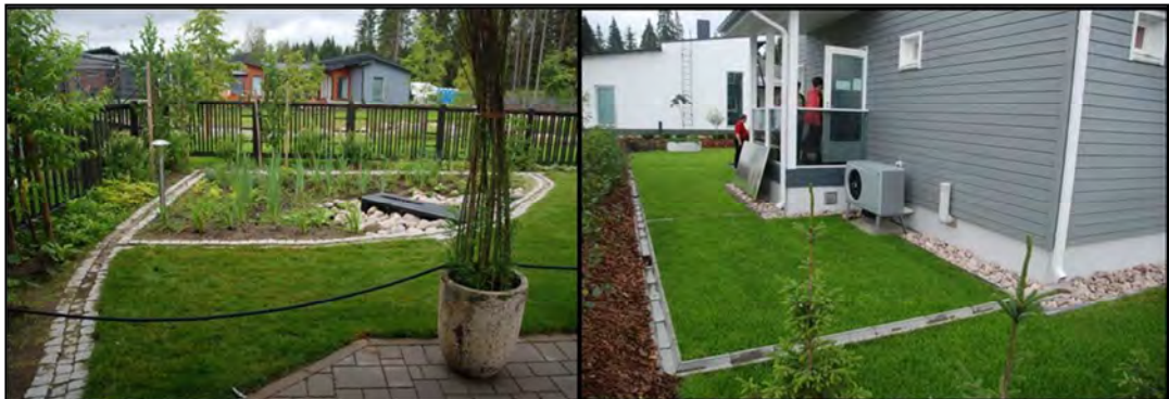
Kuva 11. Omakotitalon hulevedet johdetaan maanpäällisin kouruin tontin kulmassa olevaan sadepuutarhaan, joka mahdollistaa hulevesien hetkellisen lammikoitumisen. (Tampere, Vuores. Kuvat: FCG).
