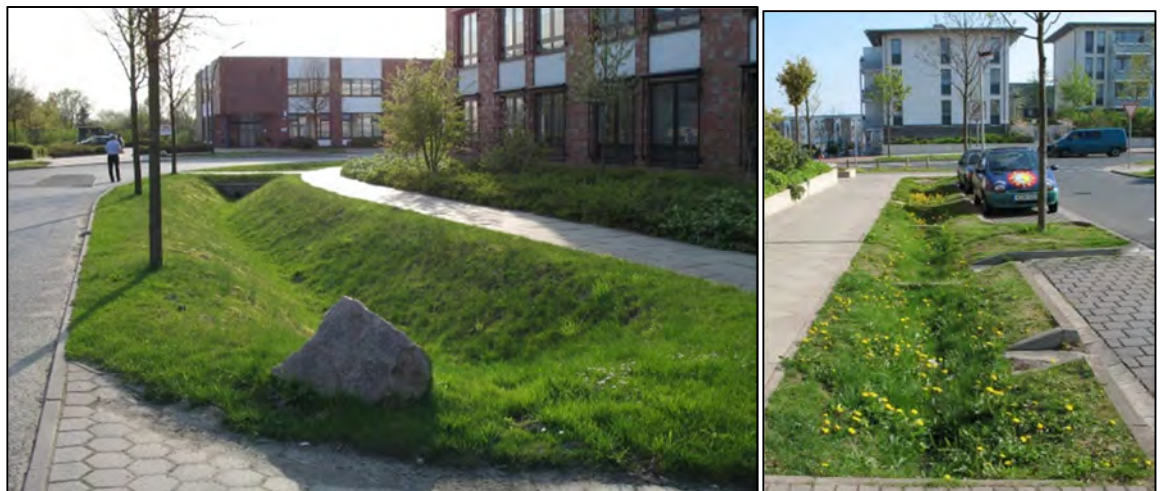
Kuva 13. Hulevesien johtaminen ja viivyttäminen viherpainanteissa (Kuvat: FCG)
