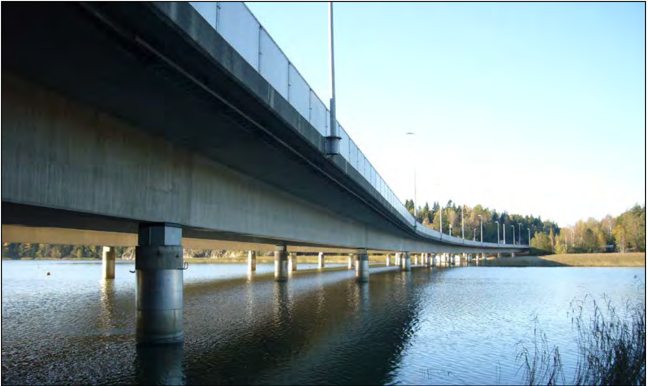
Kuva 1.19. Nykyinen meluntorjunta Sipoonlahden sillalla on suojana riittämätön ja estää näkymät ympäröivään maisemaan.
