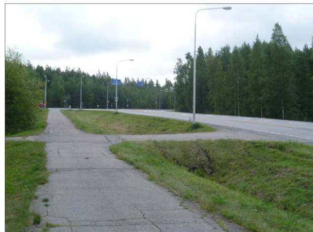
Kuva 45. Näkymä Järvenpään liittymään maantieltä 145.
