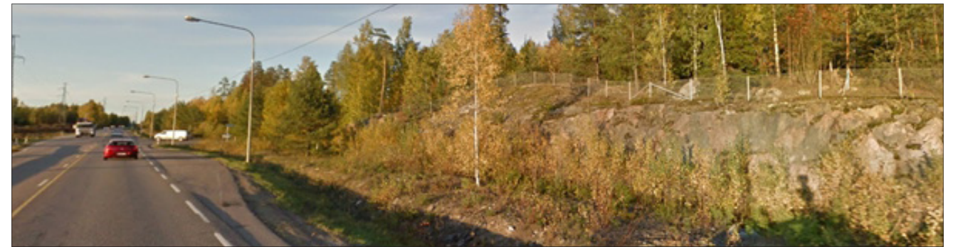
Kuva 60. Kallioleikkaus Talman alueen liittymän, Porvoontien rampin eteläpuolella. Kuvan lähde Google Maps.
