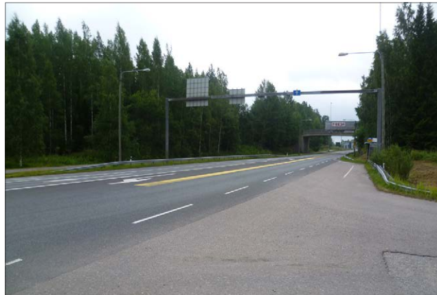
Kuva 37. Näkymä Ravuntien liittymästä etelään. Taustalla näkyy Sipoontien silta.
