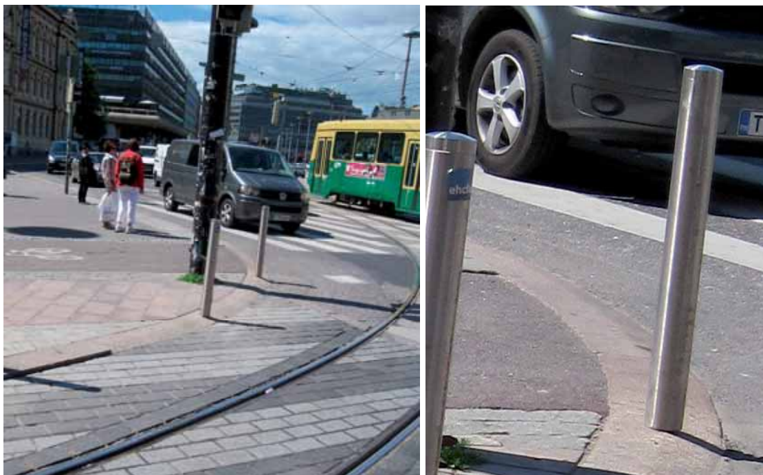
Kuva 25. Esimerkki sekä pyöräilyn sujuvuuden että esteettömyyden kannalta onnistuneesta luiskauksesta Helsingin Kaivokadulta. Luiskan tyyppipiirustus on laadittu Helsinki kaikille -projektin yhteydessä ja löytyy verkkosivulta http://www.hel.fi/static/hkr/helsinkikaikille/tyyppipiirustukset/29263_03_erotettu_jkpp.pdf .
