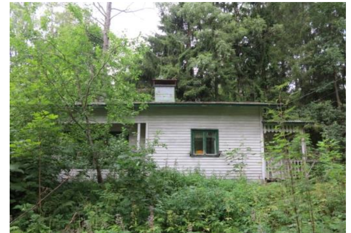
Hyvin säilynyt 1960-luvulla rakennettu kesämökki.
