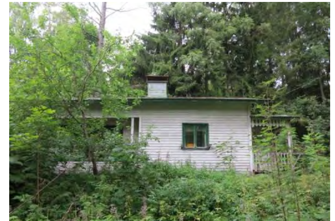
Hyvin säilynyt 1960-luvulla rakennettu kesämökki.
