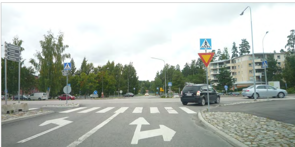
Kuva 26. Kaksisuuntainen pyörätie -lisäkilpi puuttuu mm. Uuden Porvoontien (mt 170) ja Amiraalintien liittymästä.
