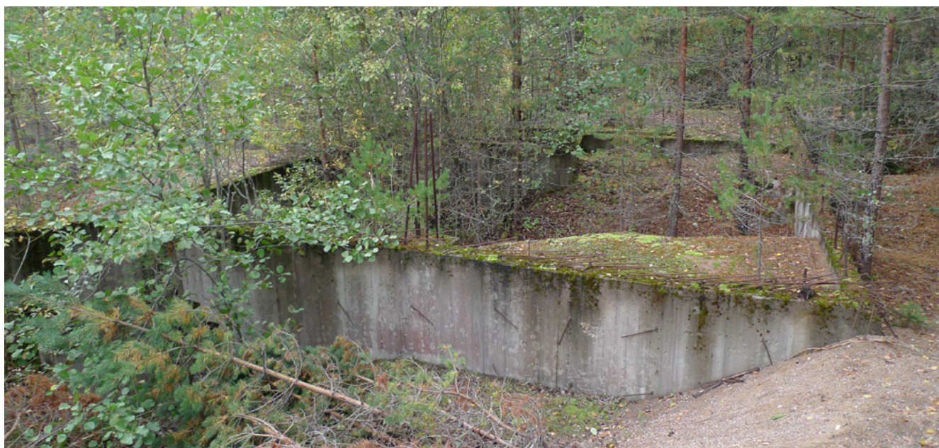
Vuonna 1988 aloitetun, mutta kesken jääneen hotellirakentamishankkeen perustukset kattavat laajalti suunnittelualueen. / Husgrunderna för hotellbyggsprojektet som startades år 1988 men inte slutförts täcker en stor del av planeringsområdet.
