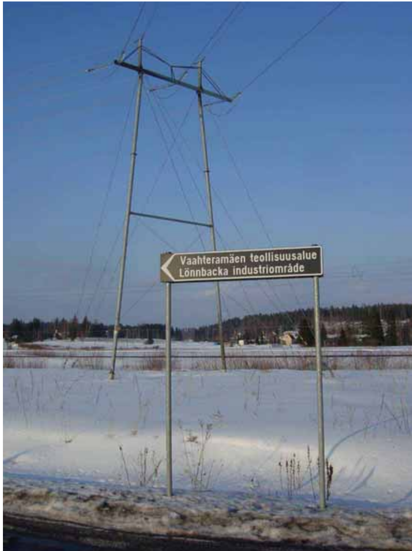
Kuva 9 Aluetta halkoo 110 kV sähkölinja
