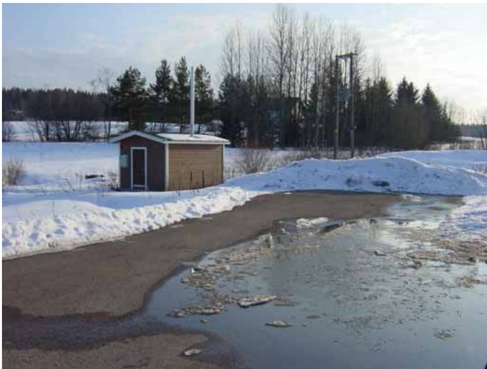
Kuva 8 Jäteveden pumppaamo maaliskuussa 2009
