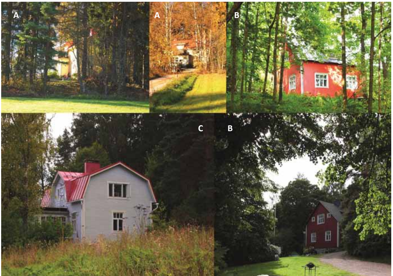
Kaava-alueen nykyinen rakennuskanta. A: Kylävuorentie 10. B: Kylävuorentie 2. C: Kylävuorentie 4. Det befintliga byggnadsbeståndet i planområdet. A: Bybergsvägen 10. B: Bybergsvägen 2. C: Bybergsvägen 4.
