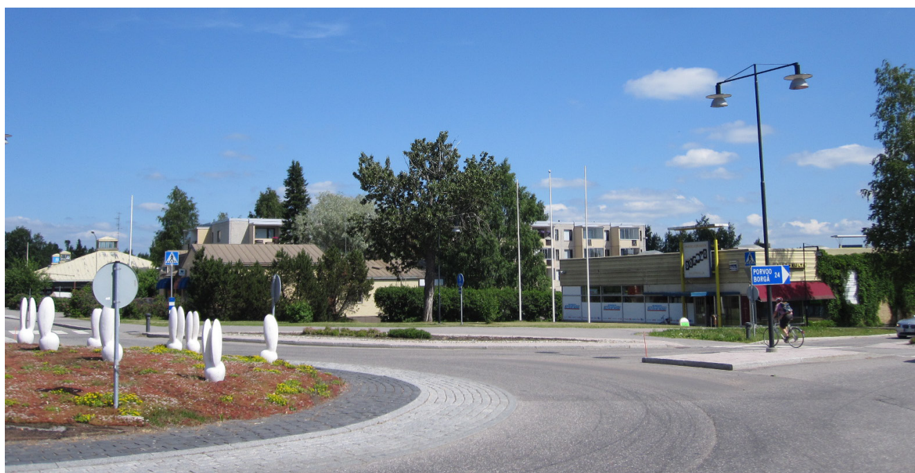
Näkymä Iso Kylätien liikenneympyrästä nykyiseen Domino-liikerakennukseen päin. Vy från Stora Byvägens rondell mot nuvarande Domino-affärsbyggnad.
