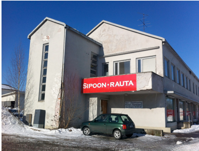
Iso Kylätien varressa sijaitseva kaksikerroksinen, sa- tulakattoinen rapattu liikerakennus on vuodelta 1943. Rakennus on mm. perustuksiltaan erittäin huonossa kun- nossa.
