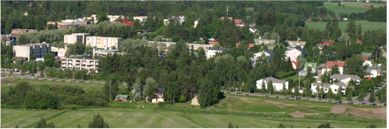
Pornaistentien itäpuolella sijaitsee asemakaavoitetulla puistoalueella neljä 1930-50-luvuilla rakennettua asuintaloo. / Öster om Borgnäs vägen finns fyra bostadshus från 1930–1950-talen på ett detaljplanerat parkområde.
