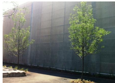
Dubbelfasad med stångaller
