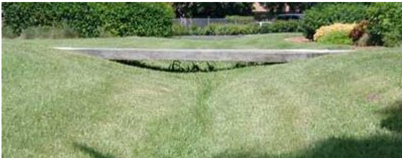
Ytvattensänka i den enklaste formen. En sänka av det här slaget kan också planteras.
